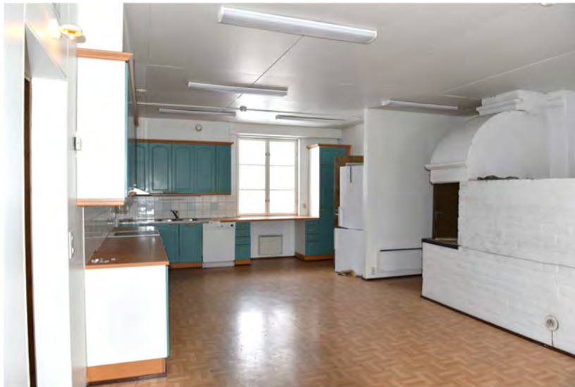
Huone 10 Tuvasta 1981 erotettu lasiseinäinen tarjoilukeittiö on purettu ja tilalle rakennettu uudet keittiökalusteet. Pieni varastotila jätettiin paikalleen. Tuvassa on säilynyt tiilinen liesiuuni. Se on väliseinän keskivaiheilla, uunin suuaukko ulkoseinän suuntaan.
