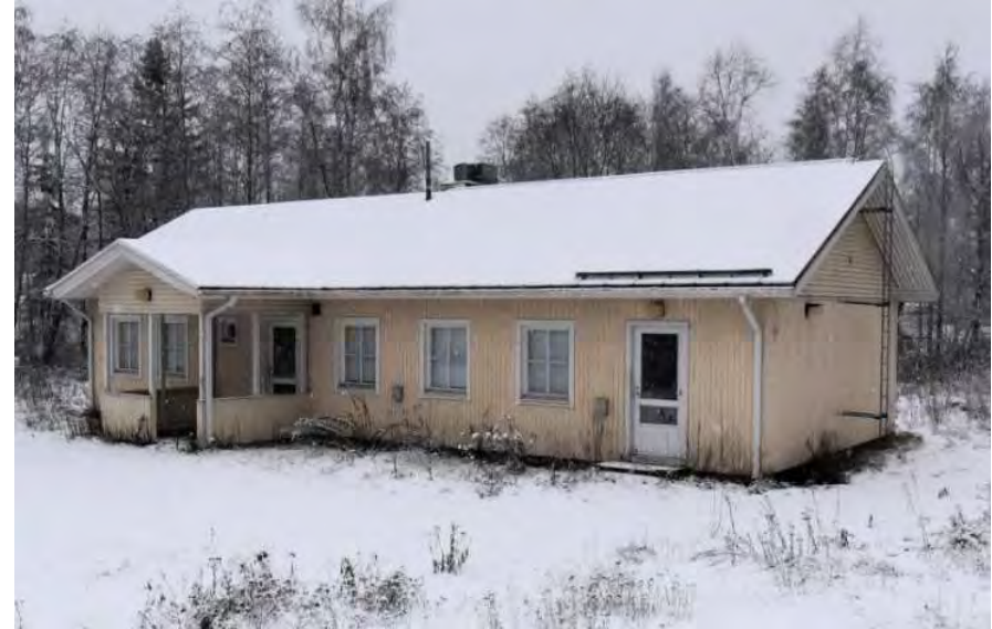
Kuva: Eteläsivu eli pääfasadi ja itäpääty.
