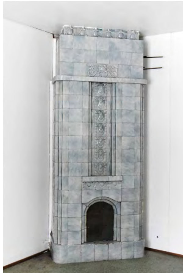
Kuva: Huone 18, entinen sali. Suorakaide, lasitettu, siniharmaa, pyörökaarinen suuaukko, syvennys, ylähyllä. Hormin savupiippu on purettu.
