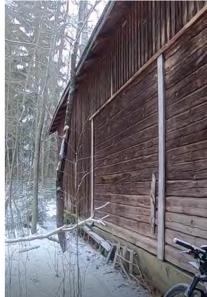
Kuva: Aitan takaseinää.
