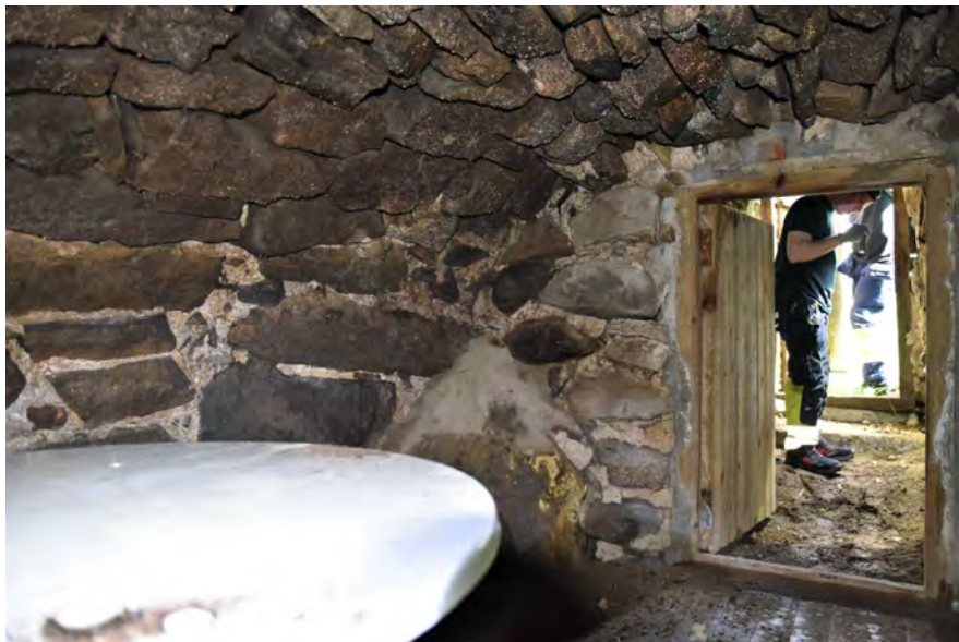
Kuvat: Kellarissa (n. 3x4 m) on komea karkeasti lohkotuista kivistä kiilaamalla tehty tynnyriholvikatto. Tekniikka on vanha. Kellari on hyvässä kunnossa. Maapohjan päällä oleva lautalattia on jossakin vaiheessa uusittu.
