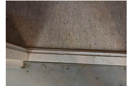
Kuva oikealla: Työhallin maalattu betonilattia, puukynnys ja muovimatto.
