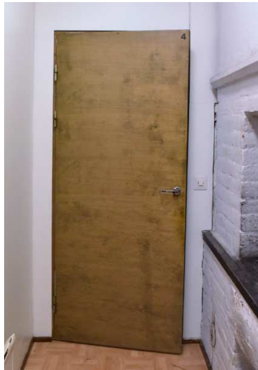
Huone nro 11: Laakaovi uunin vieressä
