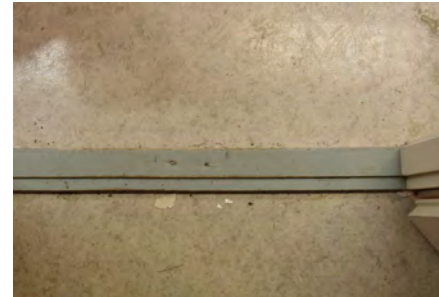
Kuva yllä: Muovimatot ja puukynnys.
