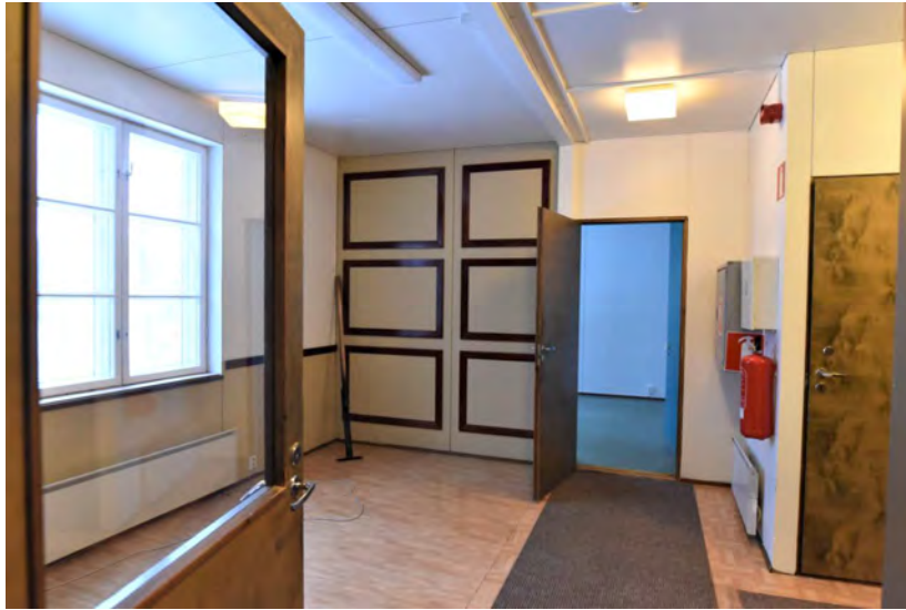
Huone 17 Päivystäjän huonetta ei enää ole. Lasiseinä on purettu ja tila yhdistetty näin eteistilaan (huone 11).
