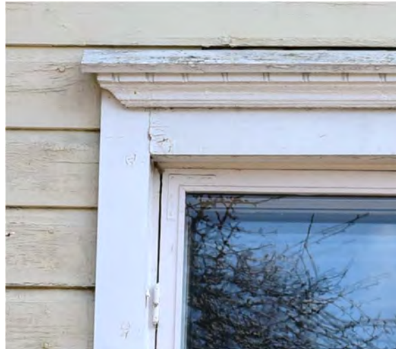
Kuva: Ikkunoiden hieman epämääräisissä otsikoissa on vanha kapea uurretulla hammastuksella koristeltu karniisilista vesilaudan alapuolella.
