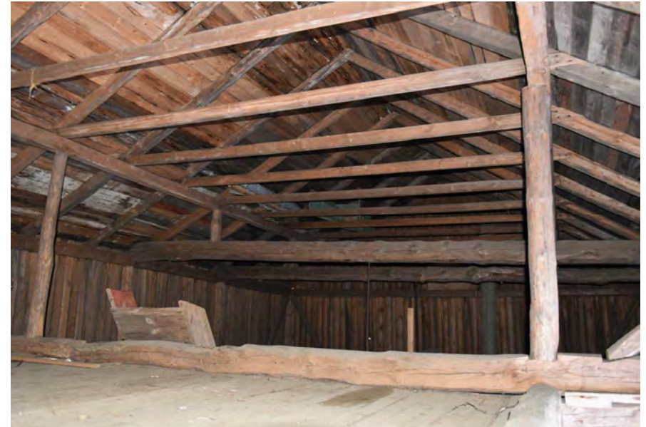
Kuva: Etualalla hirsiaittojen yläpohja ja taustalla vajan sisätilaa. Vesikaton selkäpuut tukeutuvat sivuilla seinien veisto-pyöröpuista tehtyyn pysty-, side- ja vinopuurakenteiseen runkoon. Selkä- ja kitapuiden liitoskohdan alla kulkevan kahden kannatinorren pystytuet tukeutuvat vankkoihin sidehirsiiin, joiden kannatusta on vahvistettu vajan puolella rautatangoin. Vesikaton rakenneosien liitokset on tehty loveamalla ja vahvistettu nauloin. Katonharjan suuntainen aluslaudoitus on umpinainen.
