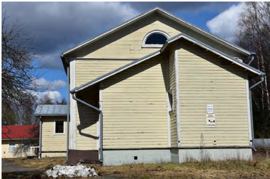
Kuva: Etelä-päädyn lisärakennus.
