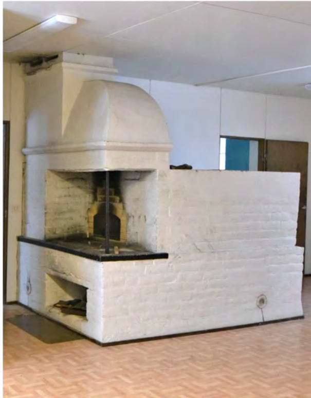
Kuva: Tuvan punatiilestä muurattu leivinuuni on itäsuomessa tyypillistä mallia, liesiuuni.
