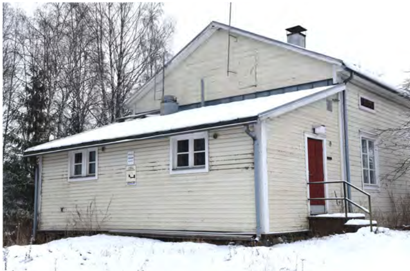
Kuva: Entinen varasto on muutettu sauna- ja pesutiloiksi.
