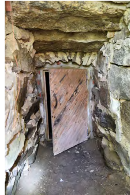
Kuva: Noin 1x2 m suuruinen eteistila eli halssi. Suora katto.
