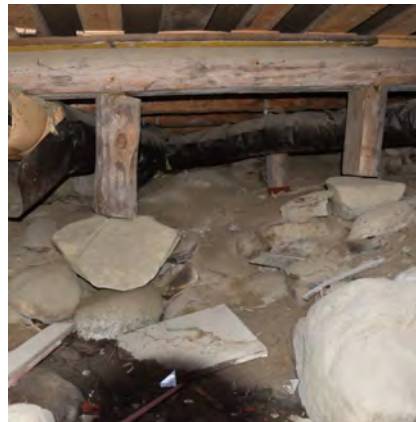
Kuva: Alapohjarakennetta rakennuksen eteläpäädyssä.
