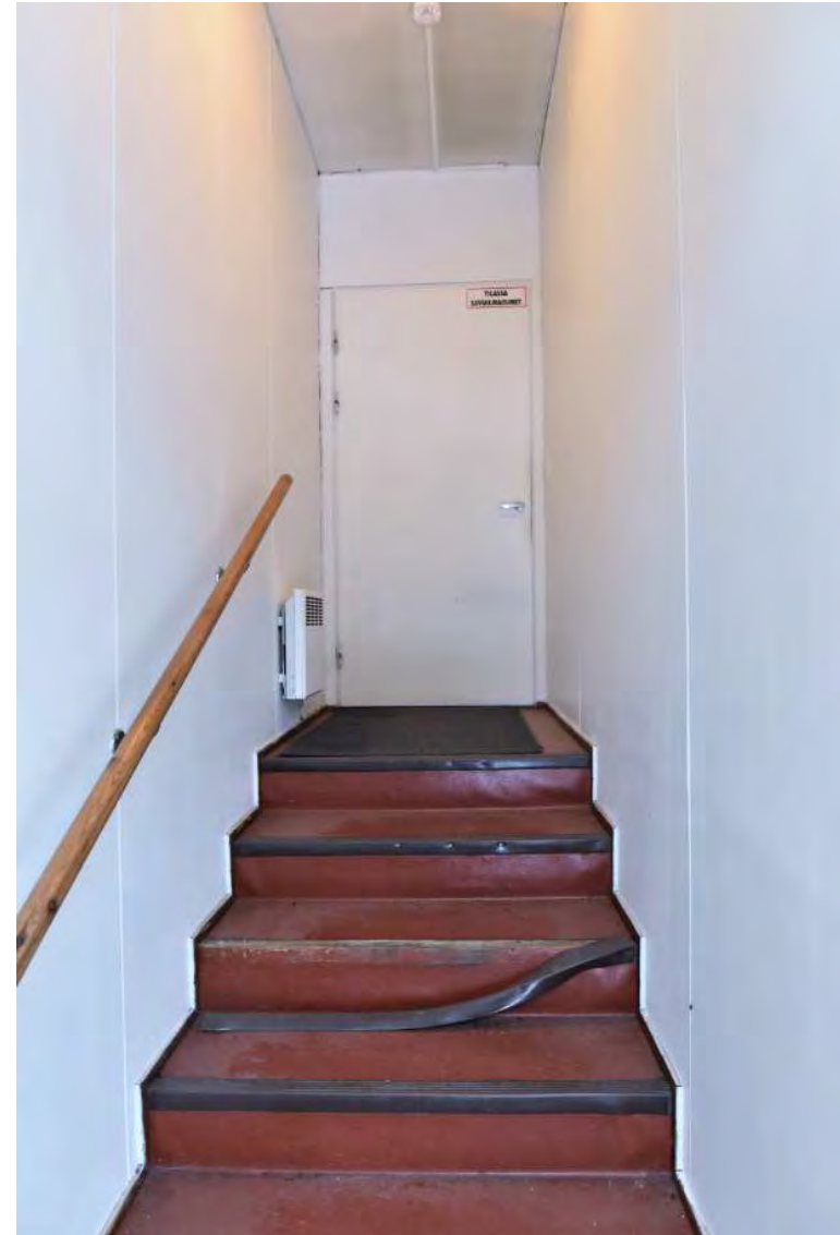
Huone 27 Eteläpäädyn lisärakennuksen tuulikaappi ja sisäporras.
