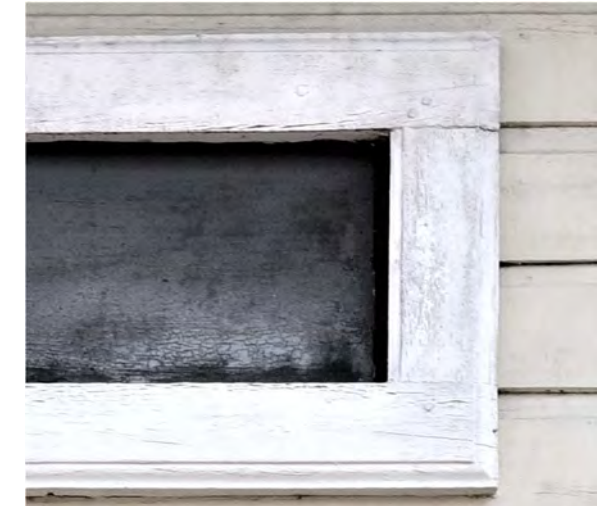
Kuva: Haukkaikkunoissa on vanhat reunaprofiililla koristellut vuorilaudat. Puitteet jäävät tumman levyn taakse (osasta puuttuvat).
