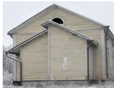
Päätyikkunat jäivät 1980-luvun lisärakennuksen alle.
