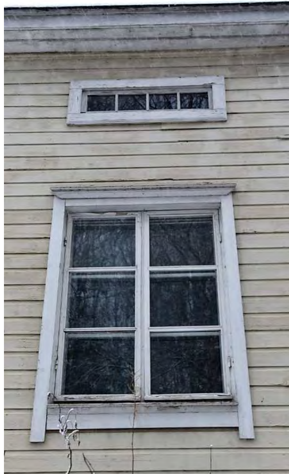
Kuva: Ikkunoiden hieman epämääräisissä otsikoissa on vanha kapea uurretulla hammastuksella koristeltu karniisilista vesilaudan alapuolella.
