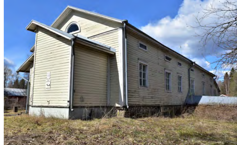
Kuva: Rakennuksen itäfasadi ja eteläpäätty.
