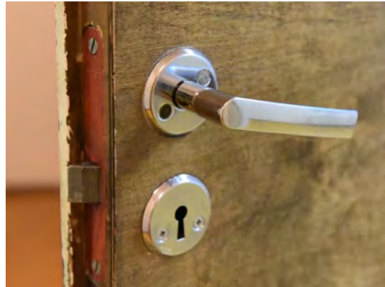
Kuva: Laakaoven painike ja avainkilpi.
