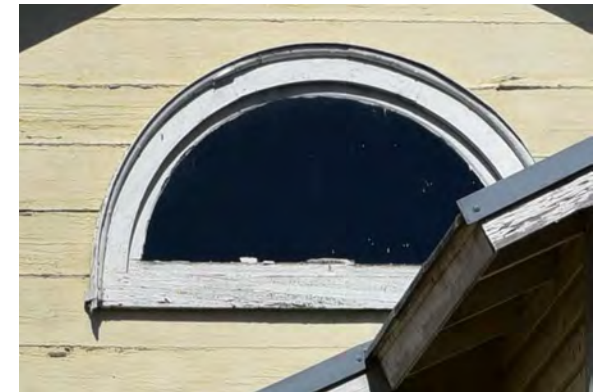
Kuva: Vanhan lunetti-ikkunan puite on peitetty tummalla levyllä.
