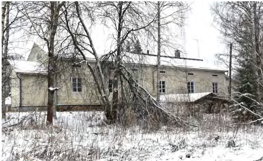
Kuva: Päärakennuksen julkisivu ja kivikellari Pieksämäelle vievän tien suuntaan.
