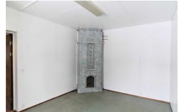
Kuva: Luja-levyllä levytetyt seinät ja katto.
